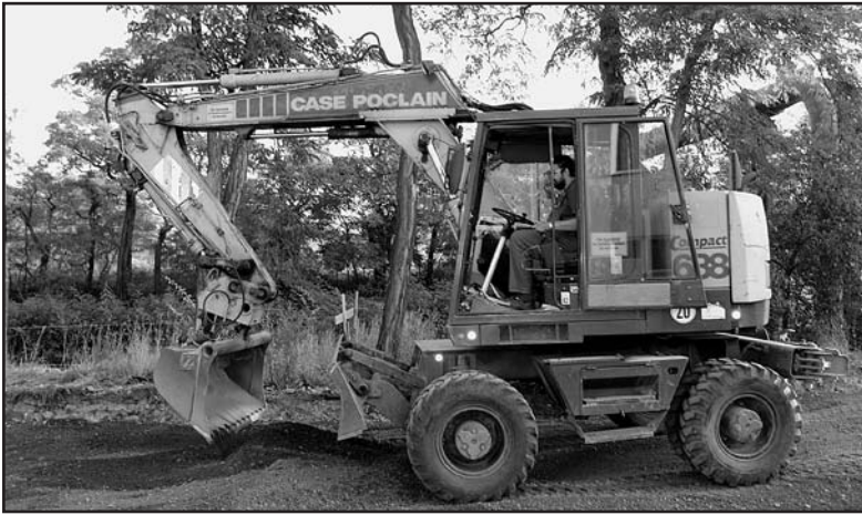
Pětadvacet nových parkovacích míst vznikne v příštích měsících v Alešově ulici v rámci její rekonstrukce. Práce tu probíhají od konce srpna a měly by skončit do konce listopadu. Obnášejí mimo jiné odstranění stávající komunikace včetně konstrukčních vrstev do hloubky 40 centimetrů. Součástí investiční akce je kromě zřízení nových zálivů na parkování i výstavba chodníku, který tu doposud scházel. Rekonstrukce Alešovy ulice je rozdělena na dvě etapy, přičemž letos se realizuje první, na úseku dlouhém asi 350 metrů, k ústí Adámkovy ulice. Celkové náklady dosahují 14 milionů korun, v letošním rozpočtu je na ni vyčleněno 9,3 milionu. Na snímku Stanislav Pokorný z firmy RRR při úpravě podloží. (text a foto: lm)
