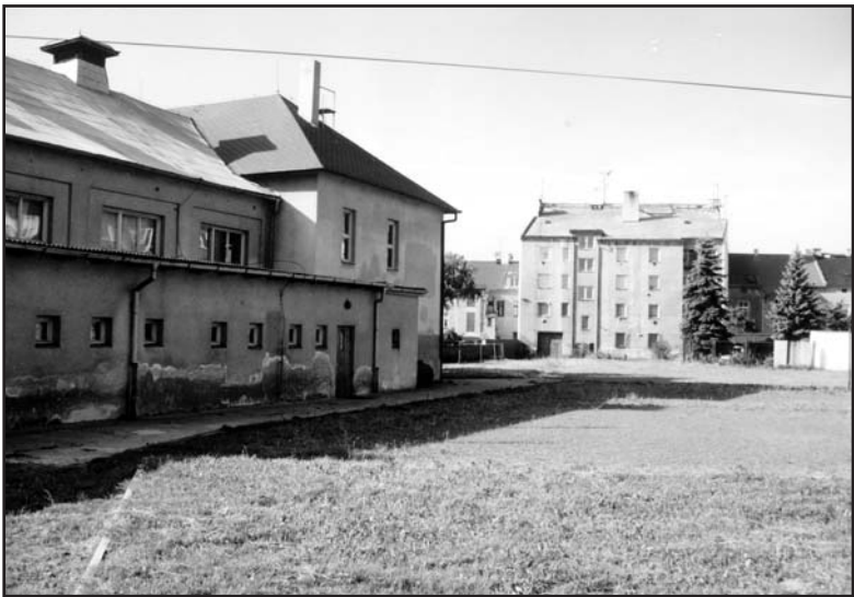
Pohled na sokolovnu. V popředí boční přístavba z let 1929 - 30, v níž fungují šatny. Pro příští rok se počítá s jejich rekonstrukcí a modernizací. V pozadí je obytný sokolský dům z roku 1923. (foto: archiv)
