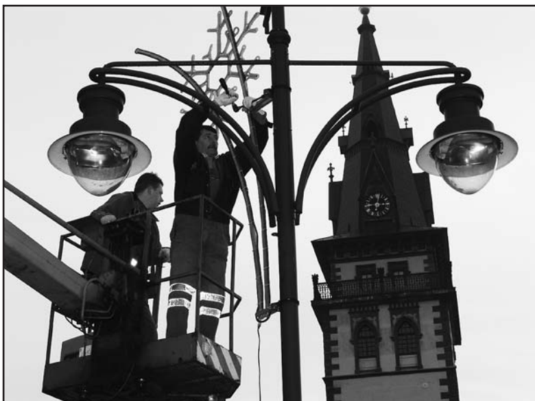
Pracovníci úseku veřejného osvětlení Technických služeb města Chomutova Daniel Hurník (vlevo) a Antonín Geiger při instalaci vánoční výzdoby na sloupy veřejného osvětlení. (foto: sk)
