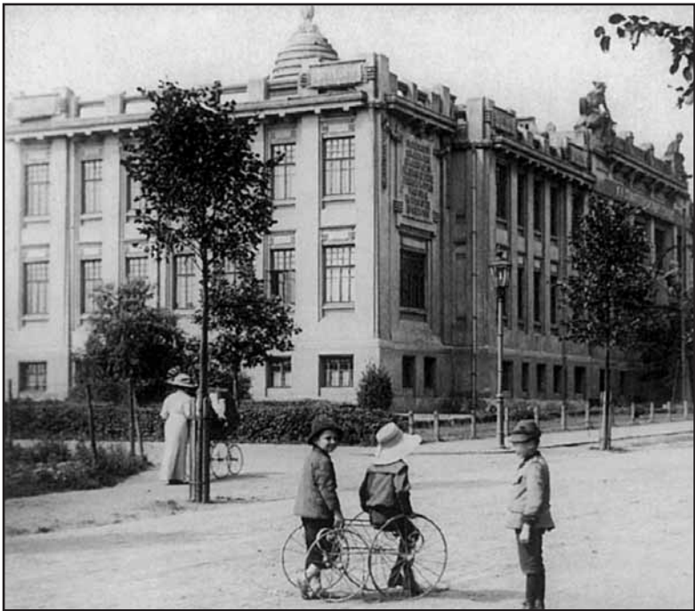
Další fotohádanka představuje objekt, vystavený před sto pěti lety. Do rubriky Zmizelý Chomutov zcela nepatří, protože ještě stojí, i když už přes tři čtvrtě století ve značně pozměněné podobě. Budova na snímku z roku 1913 slouží od svého vzniku stále původnímu účelu. Jeden z vás, kteří zašlou správnou odpověď na adresu redakce Chomutovských novin (možno též e-mailem, viz adresy v tiráži na poslední straně) nebo ji vhodí do schránky novin u vchodu do historické radnice z Chelčického ulice, obdrží publikaci Zmizelý Chomutov. Z této knihy, která je k dostání v knihkupectví DDD v Ruské ulici, naše fotohádky pocházejí. (lm)
